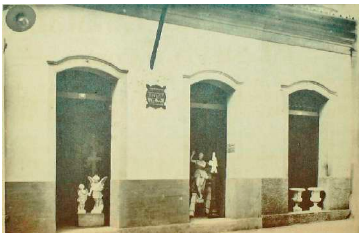
Figuras 9, 10 e 11: Fotos de lojas de materiais de construção que comercializavam ornamentos cerâmicos vitrificados em Belém: Grandes oficinas mechanicas da "Marmoaria Luzitana", rua Padre Prudencio nº13 e 15 com sucursal em frente ao Cemiterio de Santa Izabel; Loja Salvador Mesquita, localizada na Travesa São Francisco; fachada externa da loja Marmoaria Luzitana. Fonte: Indicador Illustrado do Estado do Pará - Parte II (1910).
