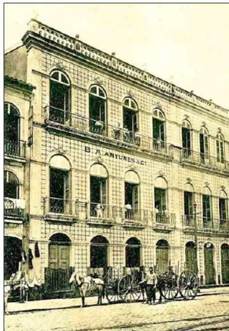
Figura 35 (acima) – Café Madrid, em frente à Praça da República. Exemplo de edificação em que o uso de platibanda estava apenas na fachada, mantendo o emprego de beirais nas suas laterais. Fonte: Arthur Caccavoni (1899).
